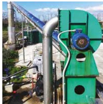
**Figura 14** - Sistema trattamento fumi esausti (Fonte: Chiara Vecchio, impianto biogas sito in Capaccio Paestum, Giugno 2022)
