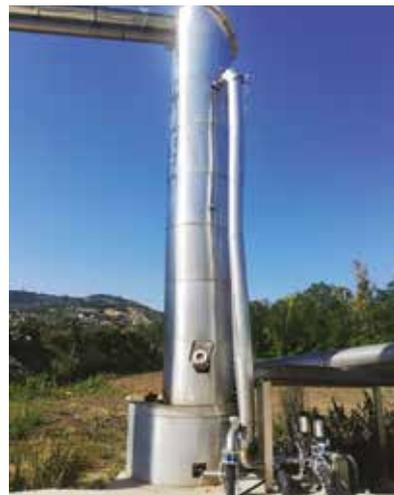
**Figura 13** - Torre di stripping (Fonte: Chiara Vecchio, impianto biogas sito in Capaccio Paestum, Giugno 2022)
