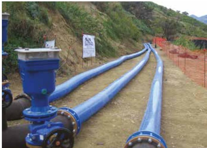
Figura 5 - Condotte idriche provvisorie. Fonte: Dipartimento della Protezione Civile
