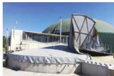
Figura 10 - Vasca di pre-carico e miscelazione delle biomasse in ingresso (Fonte: Chiara Vecchio, impianto biogas sito in Capaccio Paestum, Giugno 2022)
